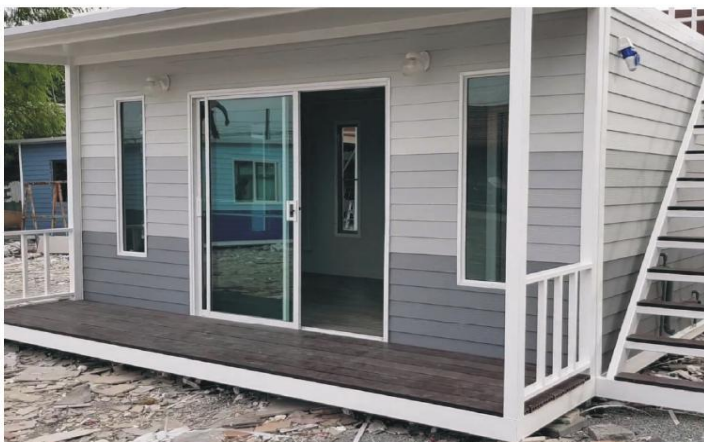
บ้านประกอบเสร็จ
