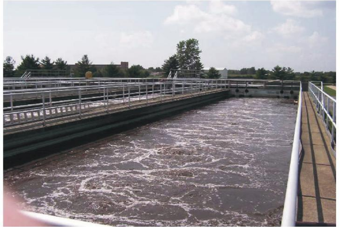
บ่อบำบัดน้ำเสีย
