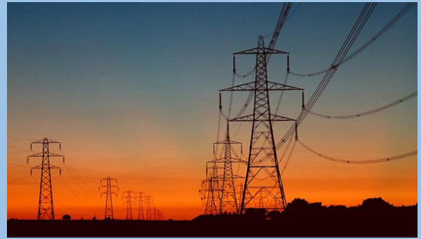
เสาไฟฟ้า
