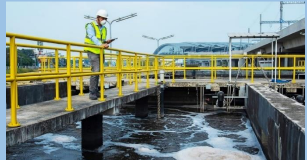
บ่อบำบัดน้ำเสีย
