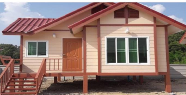
บ้านประกอบเสร็จ
